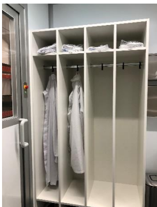
Linke Seite der Personalschleuse für Reinraumbekleidung
